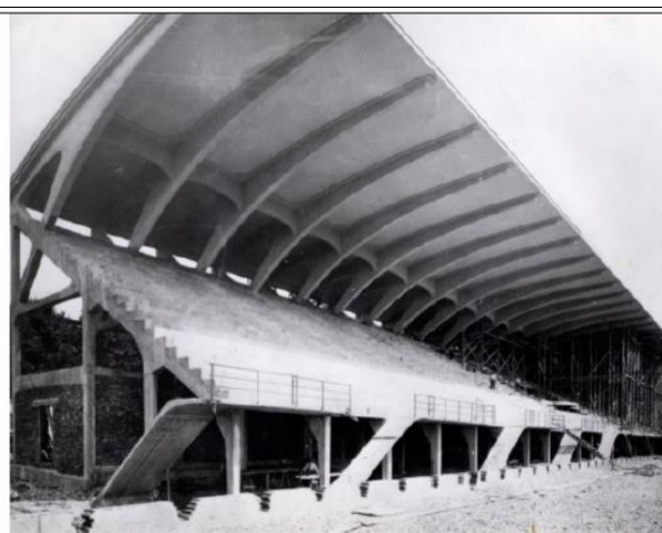
La Tribuna coperta in costruzione, fotografo sconosciuto, 1930.
