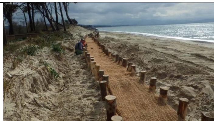
Ingegneria naturalistica antierosione al Parco della Sterpaia (Piombino, da Mori E., -Sbrilli-L. Giunti M., Bacci M. La gestione del sistema dunale del Parco costiero della Sterpaia.
