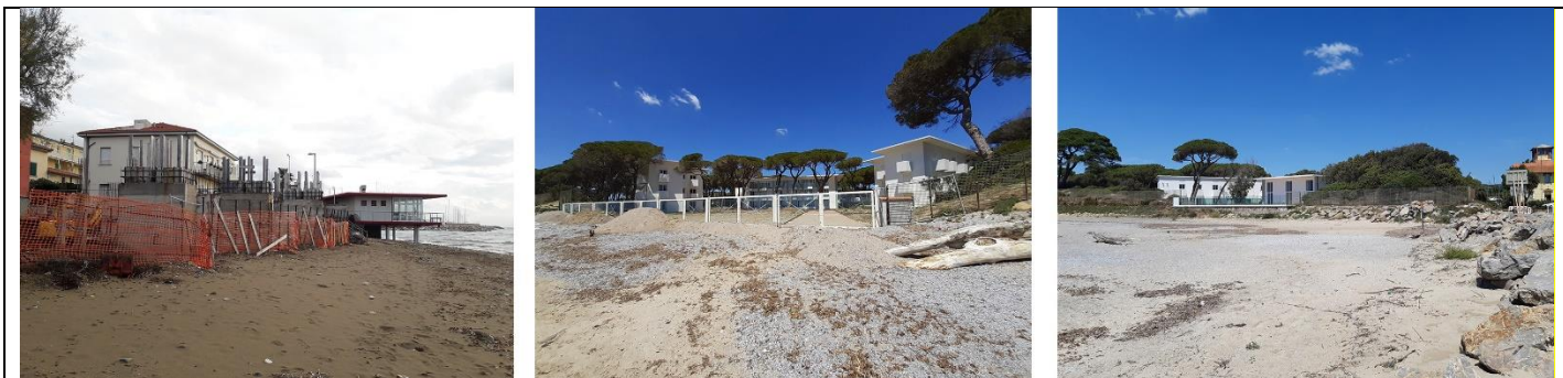
Nuove costruzioni sulla spiaggia (San Vincenzo) e recente recupero di complessi edificati sulla duna (Pratoranieri, Follonica)
