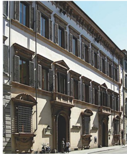
Figura 6 - AT12.01 - Facciata su Via Cavour – 2008 (immagine raddrizzata)
