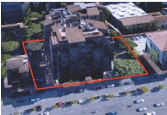
Figura 14 - AT12.Q1 Complesso Belfiore - -Foto aerea tridimensionale verso nord da Google Earthi
