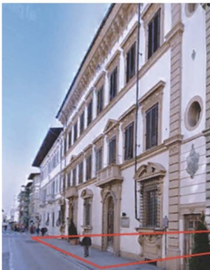
Figura 7 – Palazzo Bartolomei – Via Cavour 22 verso nord (Google Earth 1/22)
