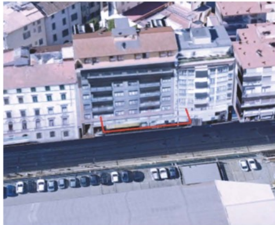
Figura 2 - AT12.01 - Facciata su Via Alamanni
