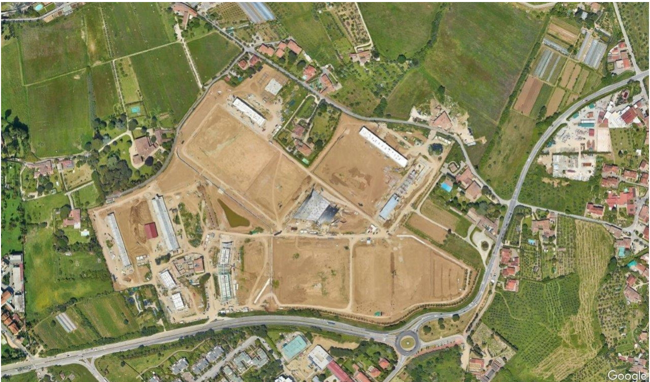
I lavori per il Centro sportivo della Fiorentina di Bagno a Ripoli nel novembre 2022
