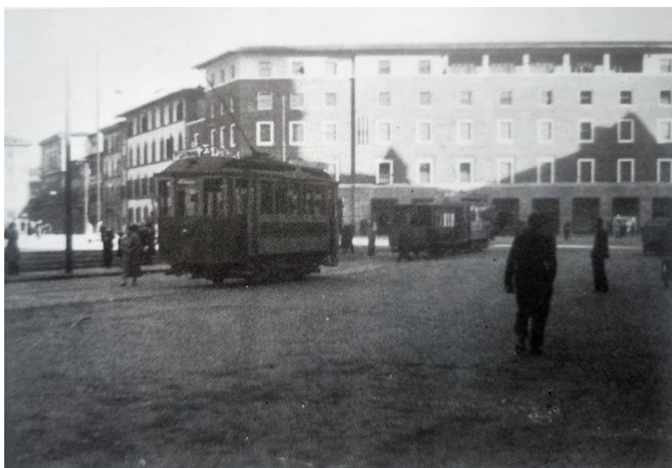
1939. Piazza della Stazione
