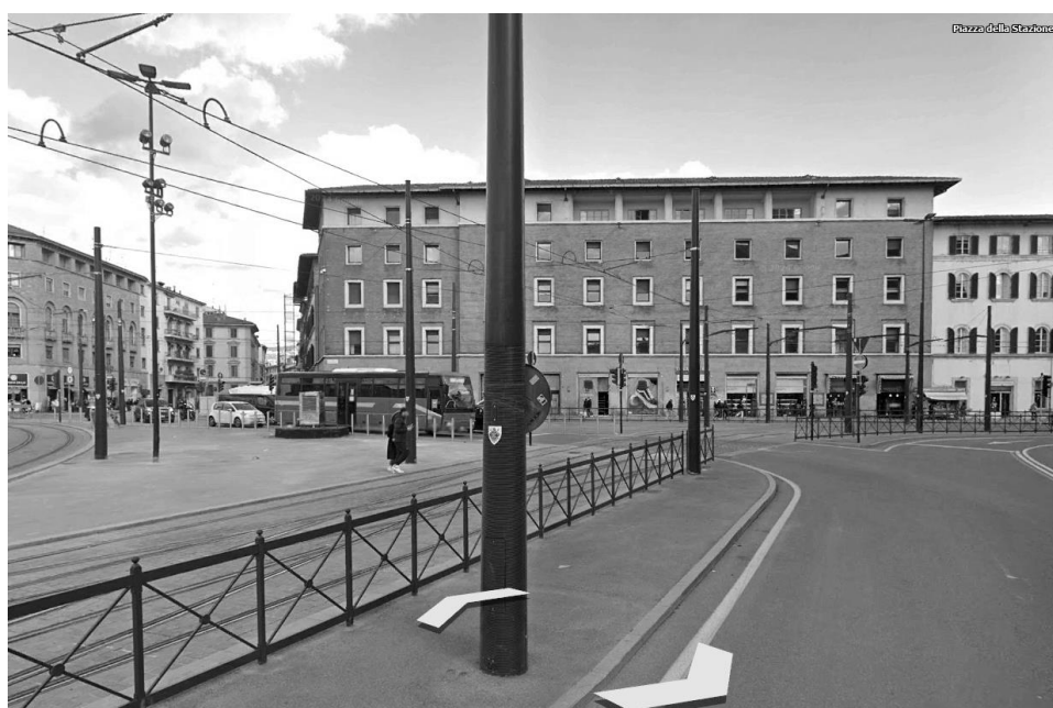
2022. Piazza della Stazione
